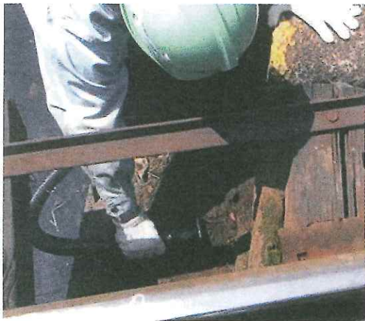
橋梁用掃除機「スイートル」使用状況
