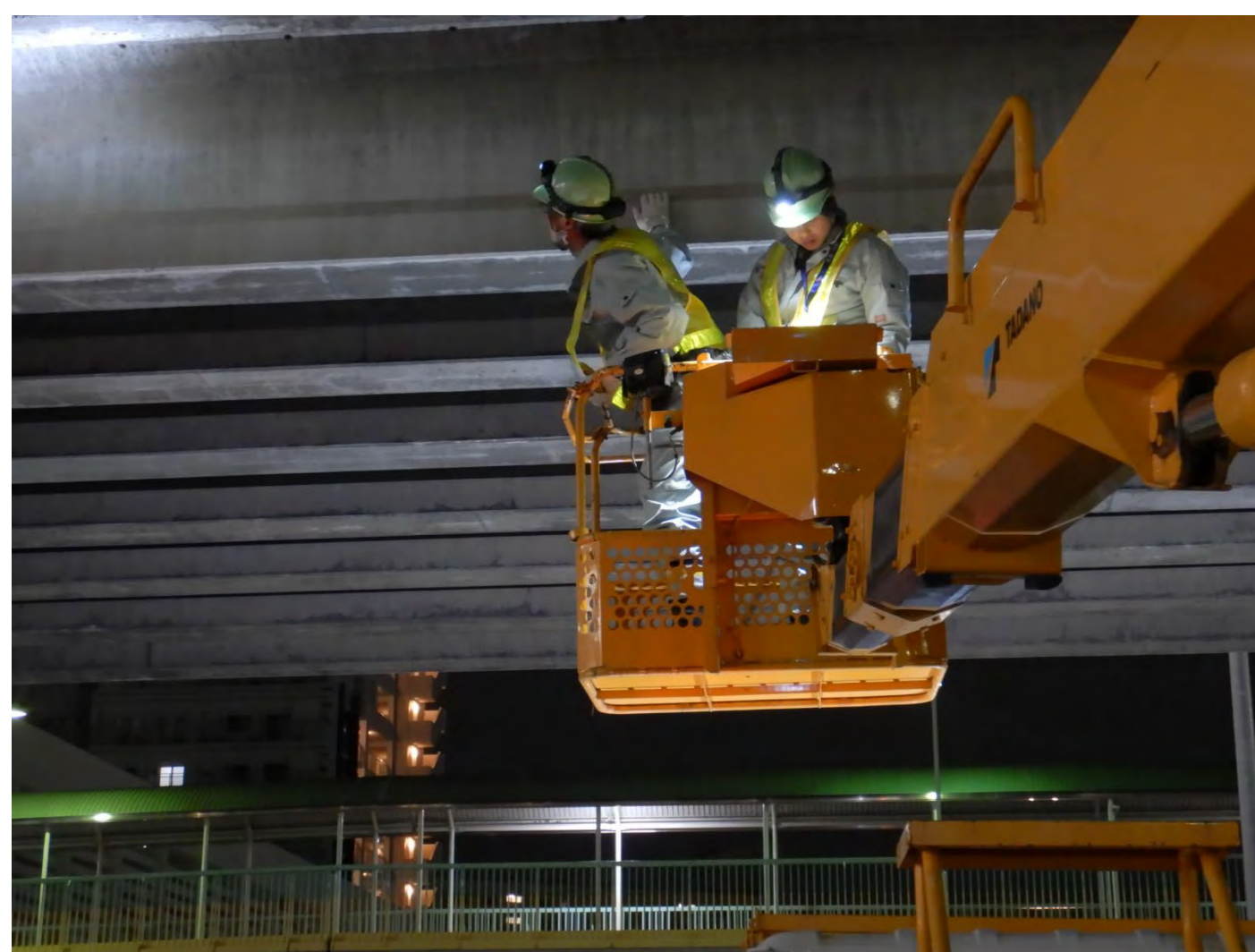
高架橋の点検
