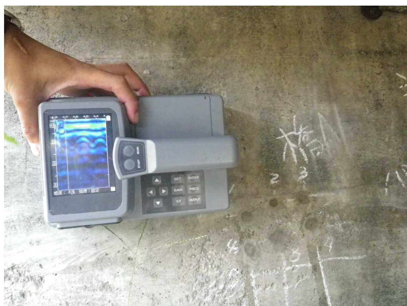
鉄筋位置調査(超音波探査)
