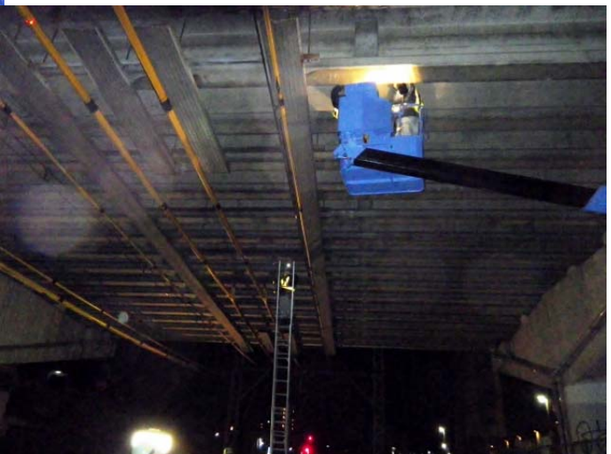
↓ 橋りょう点検 (目視・第三者被害予防調査状況)
