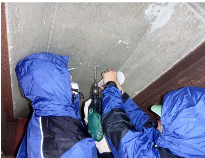
↓ 橋りょう点検 (中性化深さ測定状況)
